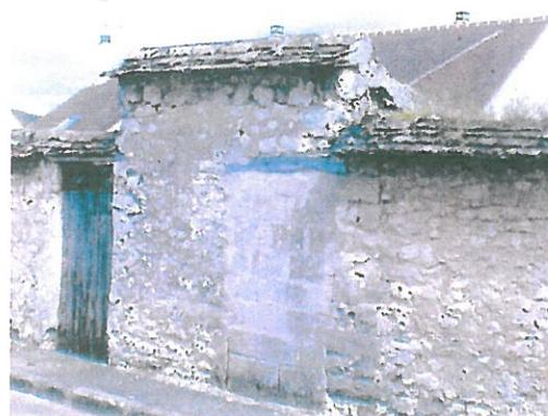
Abri à un versant dans l'angle de la parcelle, mur arrière inclus dans le mur extérieur, la pente de couverture prolonge le chaperon du mur. La porte d'accès direct à partir de la rue a été rebouchée, et pourrait être rouverte
