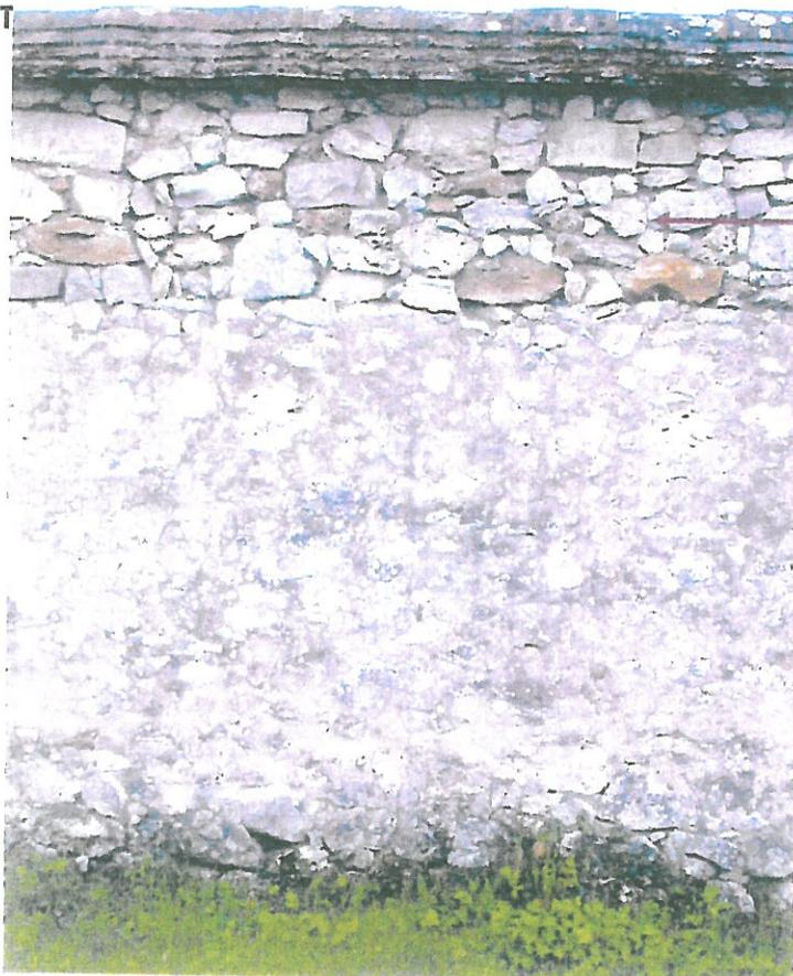
Rehausse du mur avec un parement d'appareil plus grossier, sur lequel l'enduit d'origine a totalement disparu
