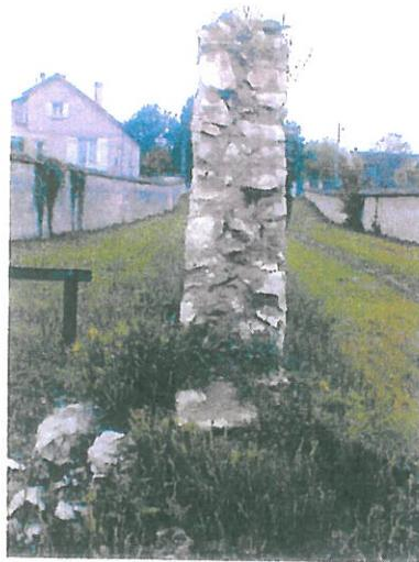
**About de mur non stabilisé : le hourdage de terre se dégrade rapidement, les deux parements se dissocient.**
