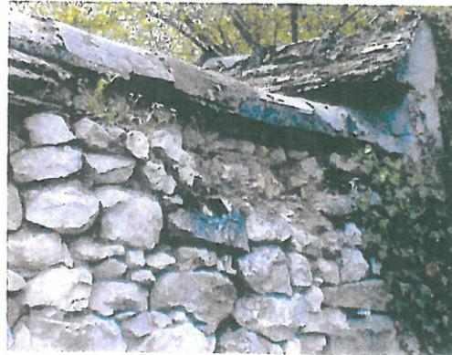
**La disparition des tuiles du chaperon favorise une brèche dans le parement qui se détériore rapidement, sous l'action de l'eau**
