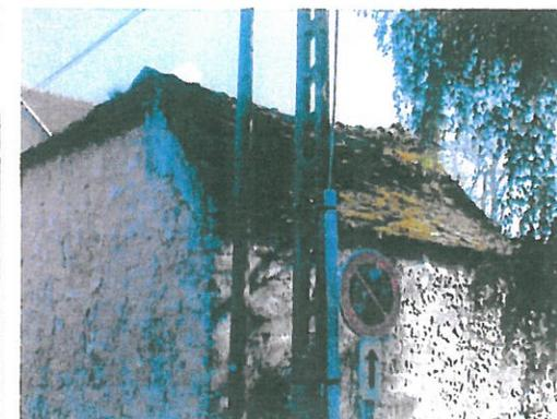
Abri dans l'angle de la parcelle, à un versant de couverture donnant sur rue. Cet abri assure le raccord entre deux murs de hauteur différente
