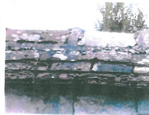
Tuile faîtière scellée au mortier de chaux avec embarure
