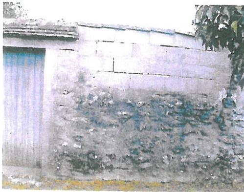
**« réparation » avec un matériau non compatible avec le mur ancien : sur le plan technique et esthétique**
