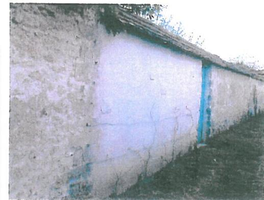
**Enduit ciment sur un mur ancien. Inconvénient technique : non compatible avec la structure du mur . Inconvénient esthétique : pierre apparentes isolées.**
