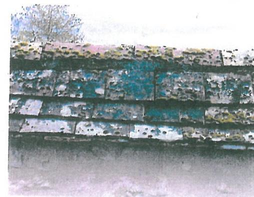
Tuile faîtière scellée au mortier de chaux sans embarure
